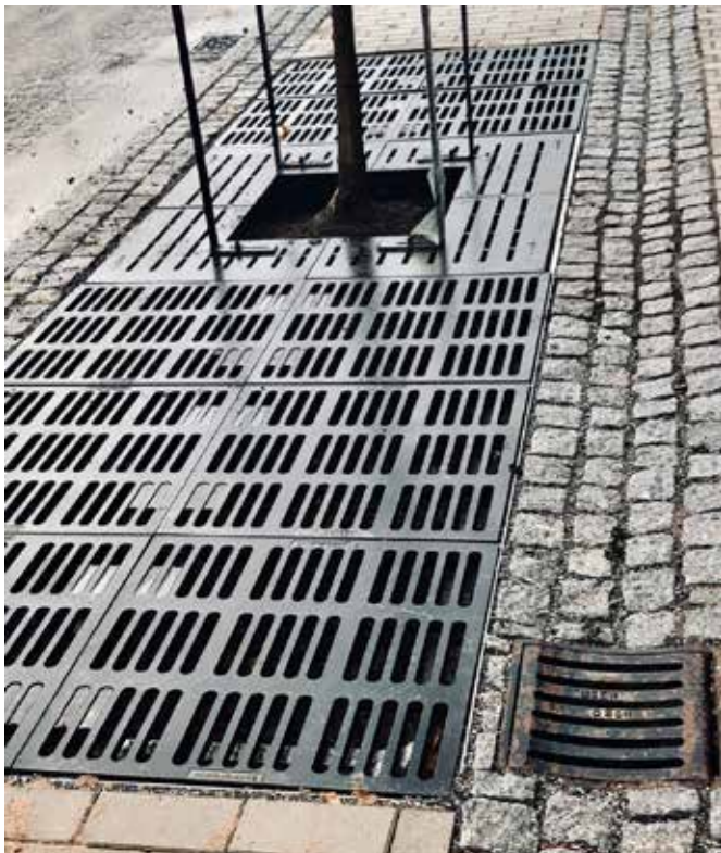
Konkav betäckning i gjutjärn 350x350 mm för rännen.
